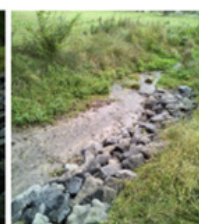
Renforcement de berge en enrochement (Béhencourt)
