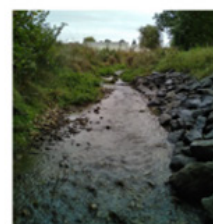
Renforcement de berge en enrochement (Béhencourt)
