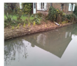
Renforcement de berge en technique végétale (Béhencourt & Pont-Noyelles)
