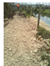
Colmatage de brèches (Béhencourt & Fréchencourt)
